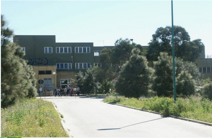
Sede centrale in via Cabras a Monserrato
